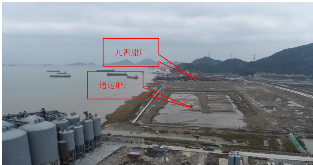
图 4.1-2 九洲船厂和通达船厂现状
